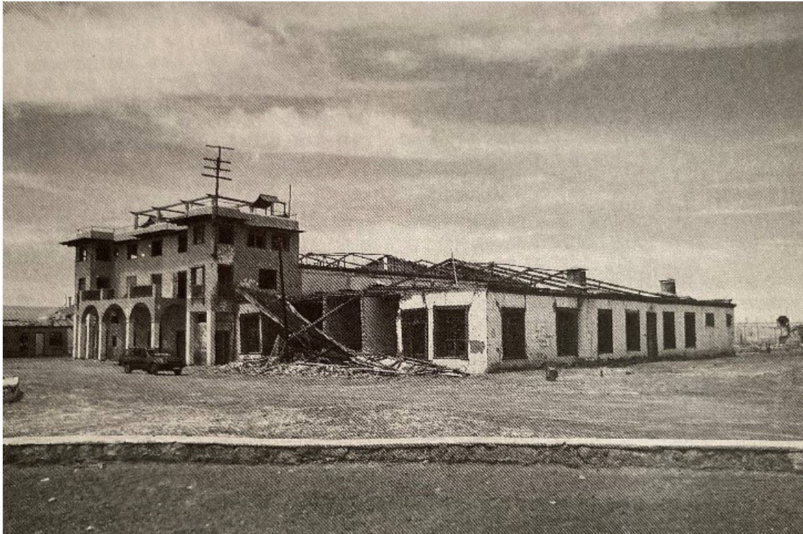
Teatro y Filarmónica, antes de la restauración de 1992
